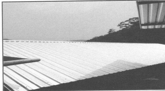
Foto 4: Se observa la sustitucion tel techo de la cocina.
