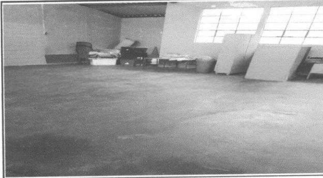
Foto 2: Se observa la finalizacion de la sustitucion del aula 1
